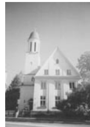
Dreifaltigkeitskirche Gemeindesaal Klausenberg 1
